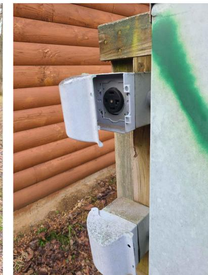
LOWER LOOP AREA 240V PLUGS - TO REMAIN - REWIRE TO NEW DISTRIBUTION PANEL
